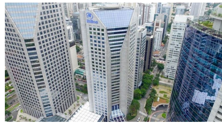
HOTEL HILTON – SP RETROFIT NA CENTRAL DE ÁGUA GELADA Capacidade total da obra: 1.050 TR Certificação LEED GOLD
