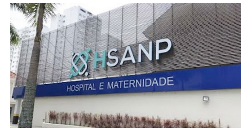
HOSPITAL E MATERNIDADE HSANP INSTALAÇÃO DA CENTRAL DE ÁGUA GELADA Capacidade da obra: 420 TR
